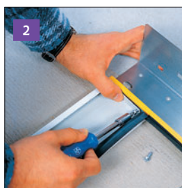
2 Rama bramy składa się z czterech profili, które należy skrócić ze sobą. (Na rys. pokazano skręcanie profilu bocznego i górnego).
