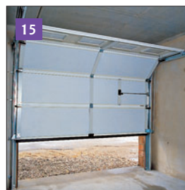
15 Próbné otwarcie i zamknięcie bramy pokaże nam czy naciąg linki wymaga dalszej regulacji. Jeśli jest prawidłowy brama otwarta do połowy powinna się zatrzymać.
