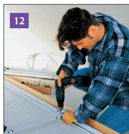
12 Poszczególne segmenty bramy garażowej są połączone na środku za pomocą przykręconych zawiasów.
