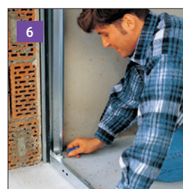
6 Kiedy rama bramy zostanie przymocowana na stałe za otworem, należy zdemonstrować szynę końcową.
