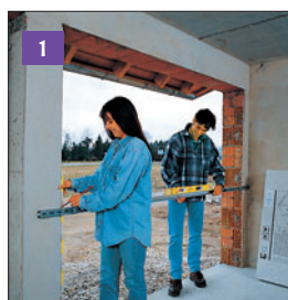
1 Przy pomocy poziomic i szyny końcowej określamy „światło otwarcia” bramy. Pomiar ten wykonujemy na wys. 100 cm od poziomu.
