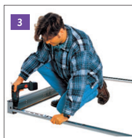
3 Do stabilizacji ramy przy montażu służy szyna końcowa. Za pomocą wiertarki przykręca się ją do dolnego wzmocnienia prowadnicy bocznej.
