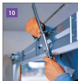
10 Ponieważ przy otwartej bramie prowadnice mają za zadanie zrównoważenie ciężaru, dlatego też należy zamocować na środku dodatkowe uchwyty.
