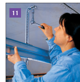
11 Następnie podwieszamy prowadnice za pomocą wcześniej zamocowanego uchwyty. Śruby z kołkami wkręcamy do stropu. W ten sposób została wykonana i usztywniona konstrukcja bramy.
