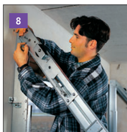
8 Wstępnie zmontowane prowadnice górne należy osadzić w ościeżnicy i przymocować śrubami.
