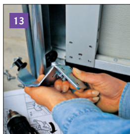
13 Roleki prowadzące należy wsunąć do profilu ościeżnicy.
