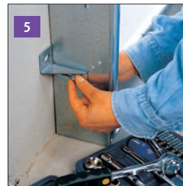
5 Boczne profile ramy przymocujemy do ściany garażu przykrywając kątownik.
