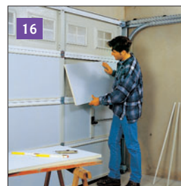
16 W przypadku bramy nieocieplonej, aby zapobiec utracie ciepła i zapewnić jak najlepsze wyciszenie można od wewnątrz zamontować płyty izolacyjne.
