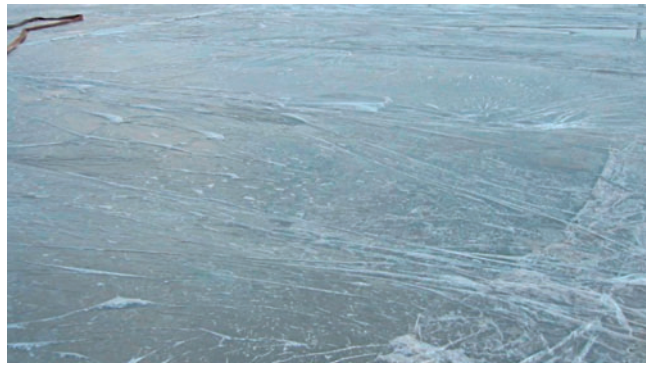
Prawidłowa pielęgnacja betonu poprzez okrycie go folią.
